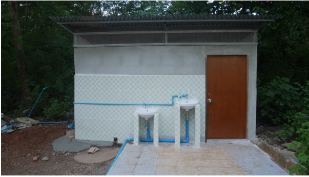
Das neue Toilettenhäuschen von außen
