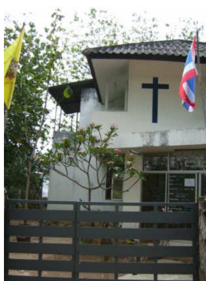
Abbildung 2: Das neue Dach über dem Büro und seinem Balkon
